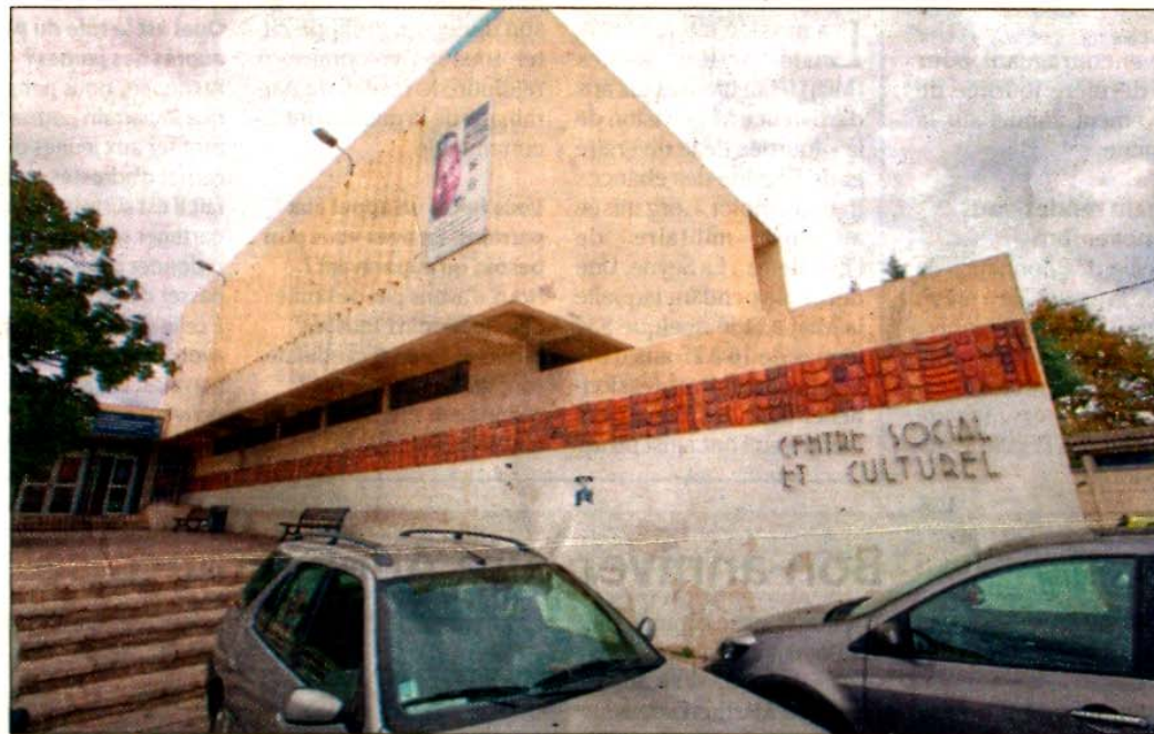
Le centre Mandela à Berthe devait subir des travaux de remise aux normes et d'extension à hauteur de 731 669 euros. Aujourd'hui, la barre du million d'euros est atteinte. (Photo Dominique Leriche)
